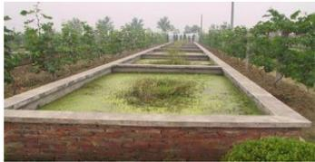
水泥池结构，每只以 10 m<sup>2</sup>~20 m<sup>2</sup> 为佳，池深 0.5 m ~0.7 m。水泥池进排水独立，排水口安装滤水插管。
